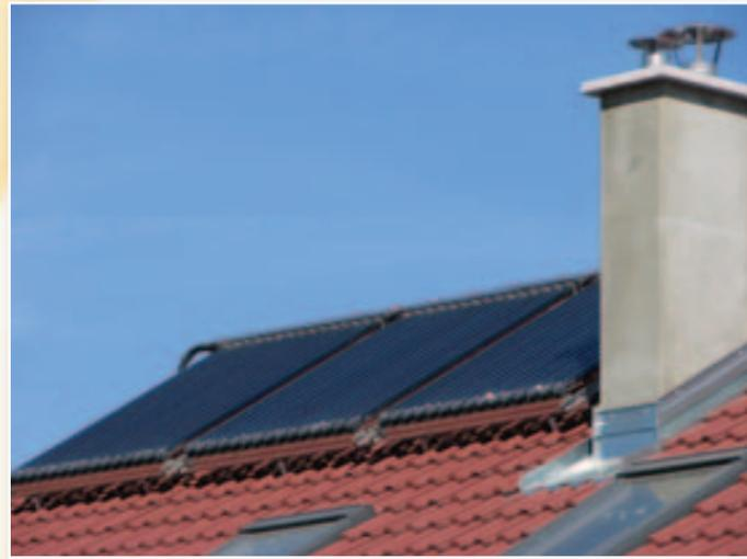
Трубчатые солнечные коллекторы позволяют эффективно извлекать тепло из солнечной радиации с высоким к.п.д. даже при экстремальных условиях.
